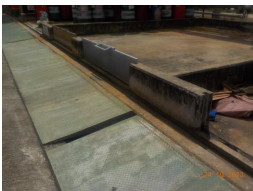
รูปที่ 3.32 Concrete Curb รอบพื้นที่เก็บพัก ของเสียประเภทบรรจุภัณฑ์สารเคมี
