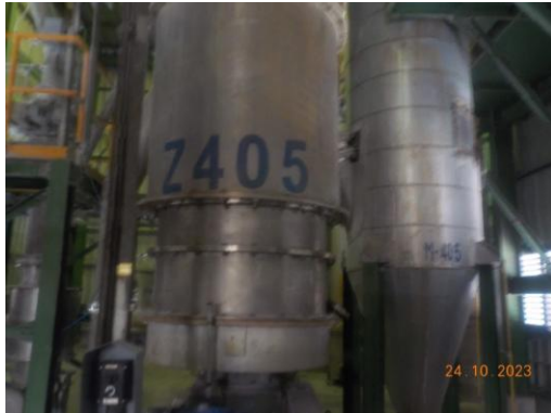
รูปที่ 3.6 ระบบดักฝุ่นแบบถุงกรอง (Bag Filter) (M-405)
