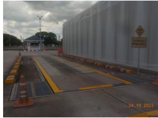
รูปที่ 3.24 จุดชั่งน้ำหนักรถบรรทุก
