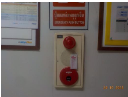
รูปที่ 3.50 ระบบตรวจจับและแจ้งเตือนไฟไหม้
