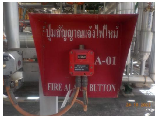
รูปที่ 3.50 ระบบตรวจจับและแจ้งเตือนไฟไหม้
