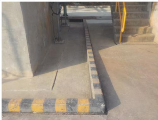
รูปที่ 3.19 พื้นที่คอนกรีตที่ลาดเอียง เข้าหาบ่อดักน้ำ (Catch Basin)
