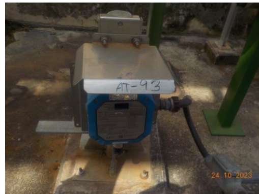
รูปที่ 3.49 Gas Detector
