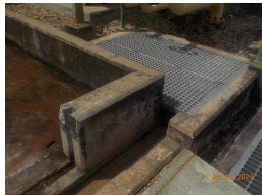
ร่องระบายน้ำฝนปูนเปื้อน และร่องระบายน้ำเสีย
