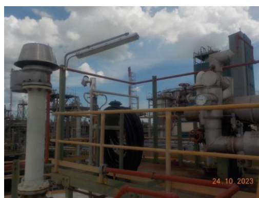
รูปที่ 3.5 ระบบท่อรวบรวม Vent Gas
